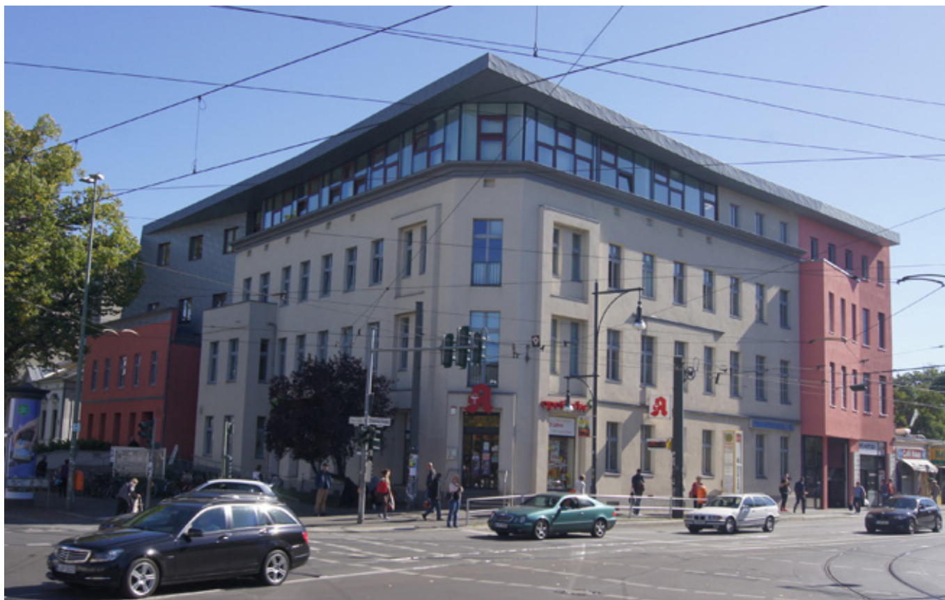
Fachärzteezentrum Berlin Pankow nach Fertigstellung
