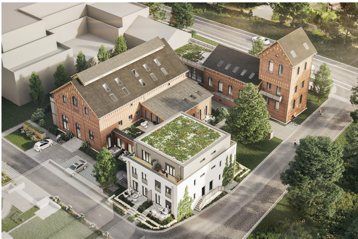
Leuchtgaswerk N°1 Nauen - Apparatehaus, Ofenhaus, Quadrohaus
