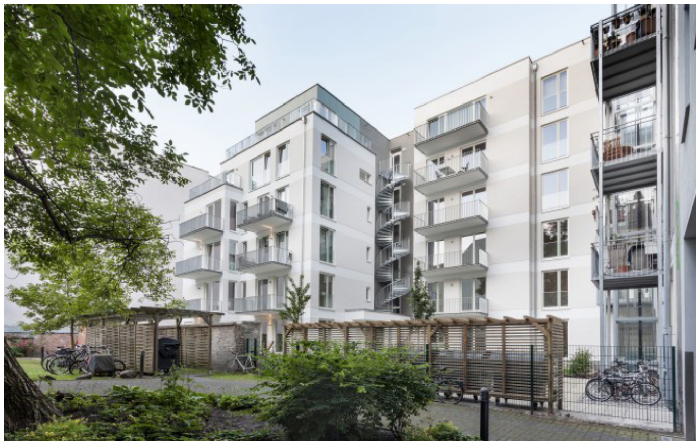
Grünberger Straße 17, wolff:architekten
