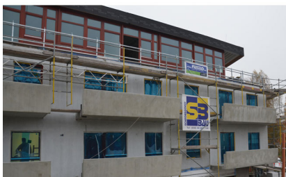
Baufortschritt November 2014 Foto: 2BPlan
