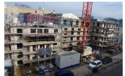
Baufortschritt Februar 2018 Foto: vangeisten.marfels architekten
