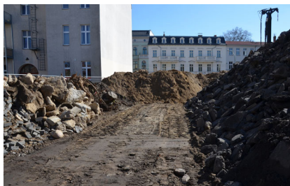
1. Spatenstich am 24.03.2017 Foto: 2BPlan
