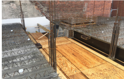
hochbewehrte Stützen Decke über 1. OG, 01/17 Foto: 2BPlan
