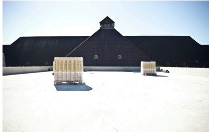
Dach mit Blick auf Altbau Foto: Dragan Dragin
